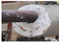
左の写真は2009年に建物にエアロゲルを設置した物ですが2024年現在でも性能を維持し断熱効果を発揮しています。他の断熱材を使った場合、5年～10年以内に能力低下による手直しが必要とされます。高い品質の提供をする事により事業主は資産価値を高める事が可能である。EPC建設会社も高い品質の製品を供給する事により信頼を得る事が出来る。基本、エアロゲルの効果は半永久です。（現在の実績で15年経過した物でも全く問題無し）一般商材（グラスウール等）は約5年で能力が無くなります。
