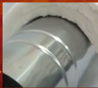
■ 配管まわりの断熱補強 (冷温・熱風ライン)
