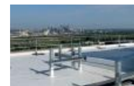
冷凍倉庫 屋根
